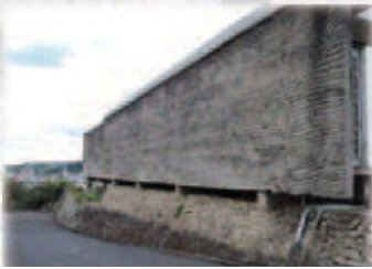
グラフィックデザイナー 「粟津 潔」作の外壁 (生物や大地の営みを表現している)
