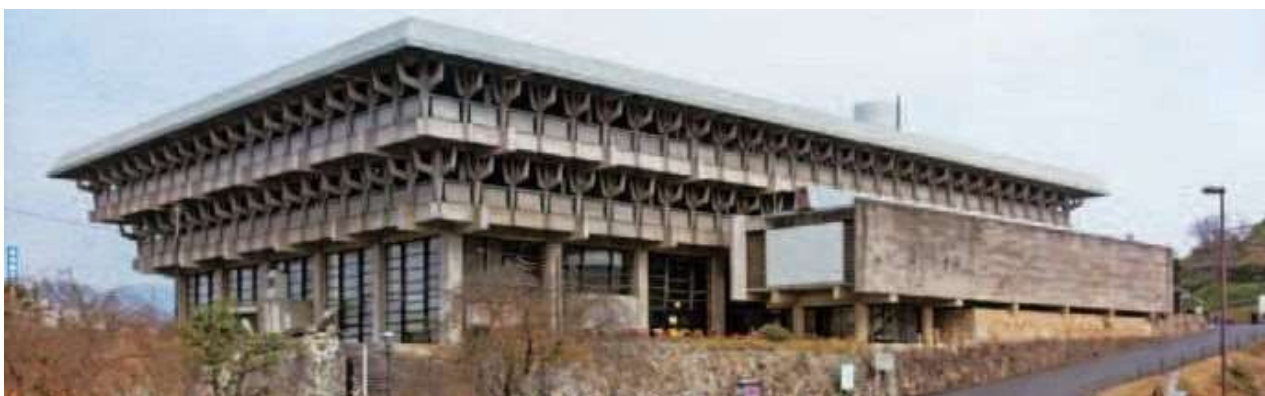
▲現在の津山文化センター。建築家の川島甲士は、「斗拱」という日本の伝統的な建築技法を大胆に取り入れた。(写真: CasaBRUTUS No.178 特集記事より抜粋)
