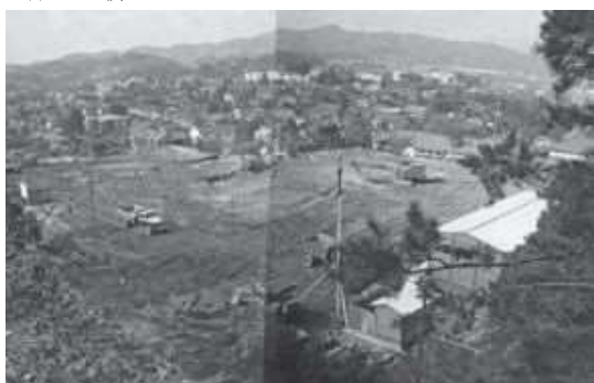
▲津山文化センターは昭和39年10月14日、起工式を終え、いよいよ建設工事が始まった。
